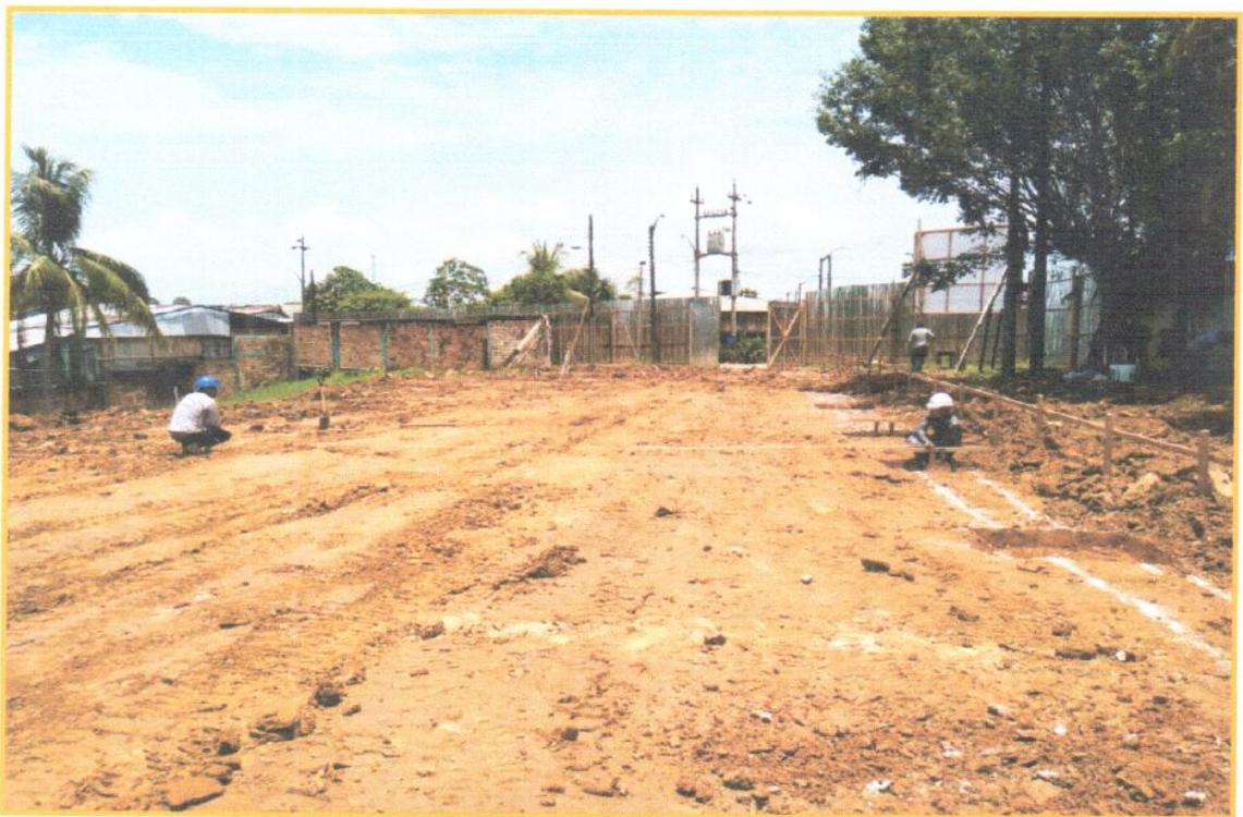
FOTO N° 11: Colocación de estacas con niveles fijos.
